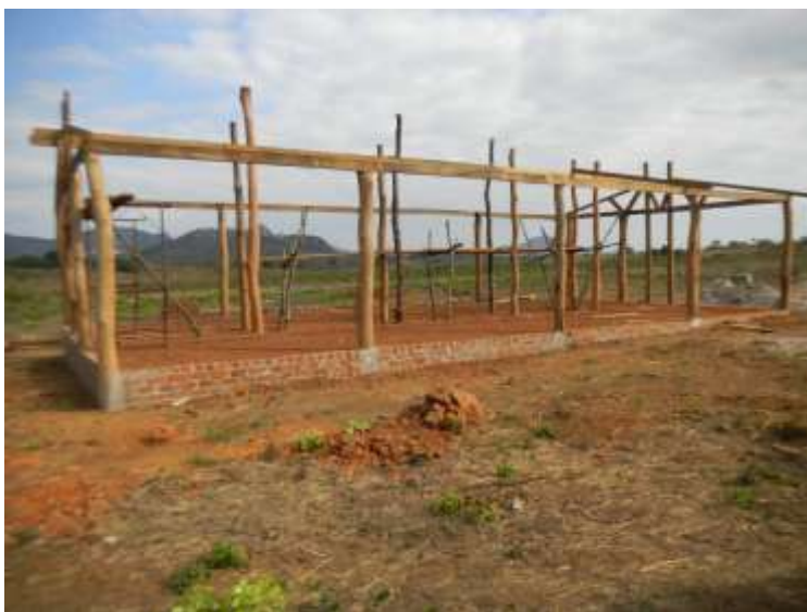
労働契約が問題になっているブラジル人企業家のプランテーション内に建築中の建物（撮影：船田クラークさん、2013 年 7 月 26 日）
