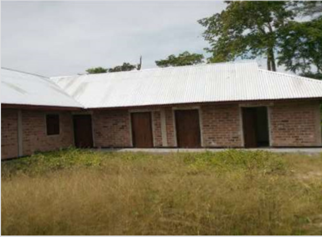
Fig 4. Centre de santé du groupement Yanongo (en finissage)
