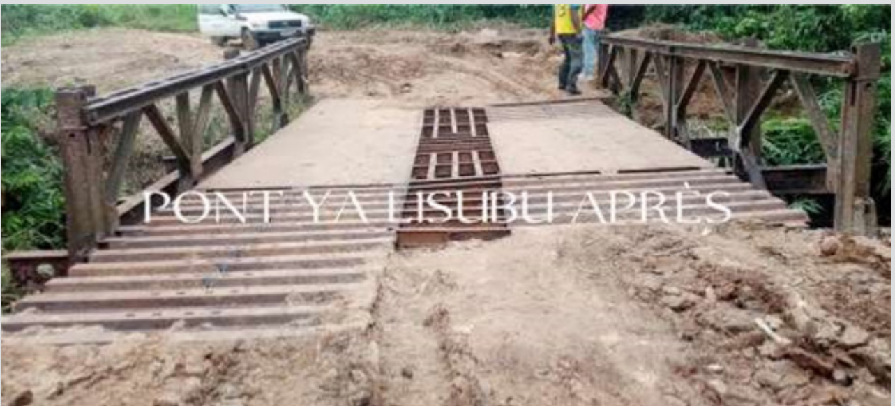
1.3.4. état du pont ya lisubu après l'intervention de KKM2
