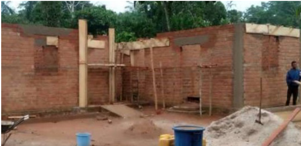
Fig 6. Centre de santé de Bolombo 1 (en construction)
