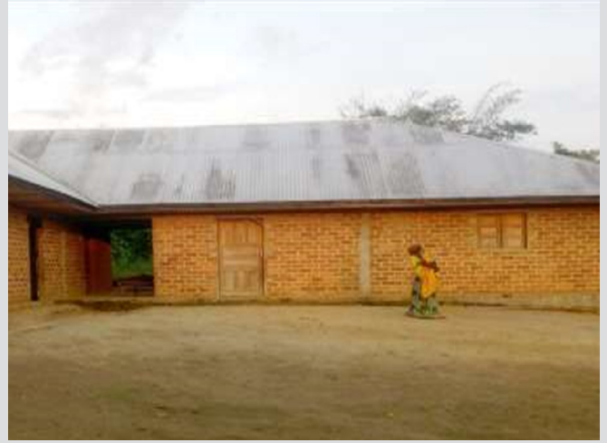
Fig 5. Centre de santé du groupement Mwando (en finissage)
